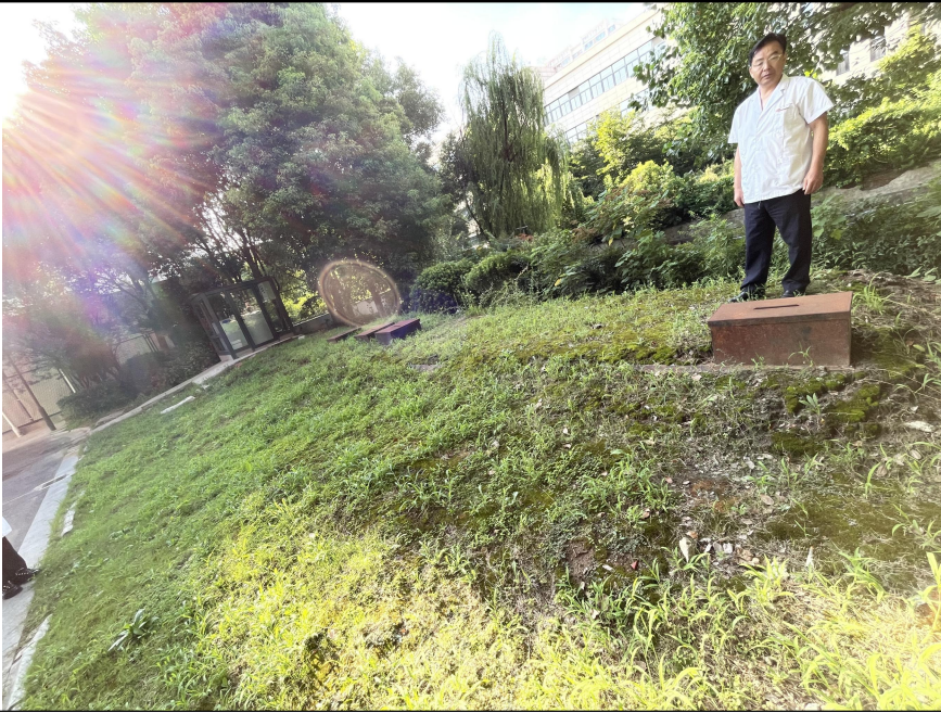
地埋式污水处理站、污水站各单元格加盖
